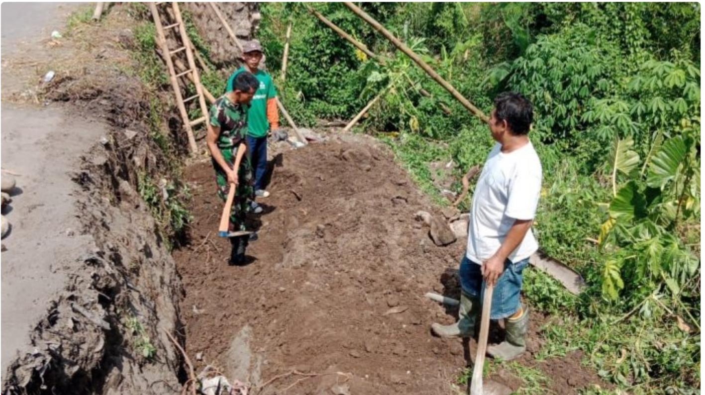
Babinsa Koramil Ceper Bersama Warga Karya Bangun Talud Jalan
